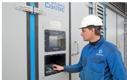
Испытания АГС-940.0 на участке 505–544 км МГ Пунга – Вуктыл – Ухта II (3-я нитка) DN 1400 Сосногорского ЛПУМГ ООО «Газпром трансгаз Ухта»
